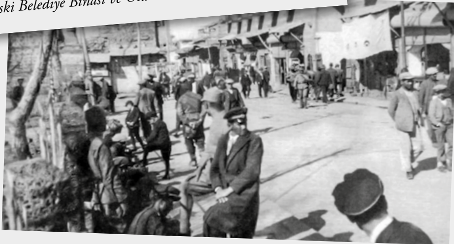
Eski Belediye Binası Önünden Hasan Paşa Hanı
